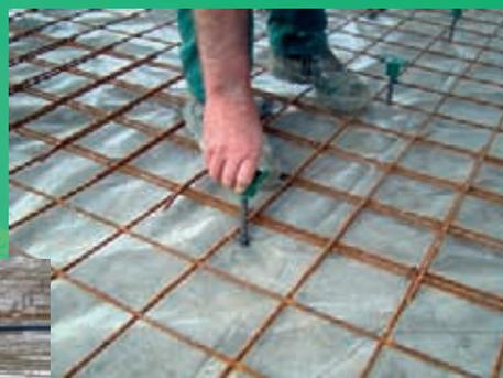
Colocation du supports en pvc sur des piquets de fer de 12mm
