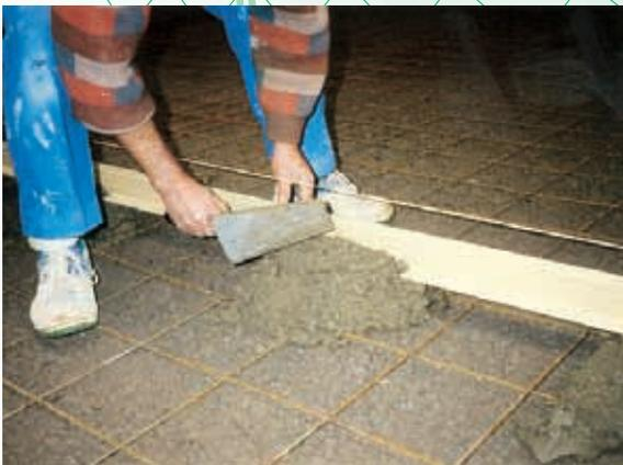
Niveau de la dalle sur la pointe de la baguette
