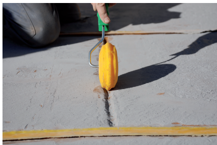
Repaso de juntas con Roler o taco.
