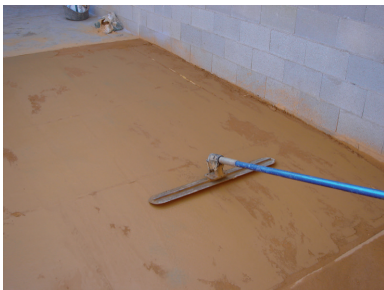
Base capa rodadura y pigmentación. Alisado de la rodadura. Espolvoreo de desmoldeante.
