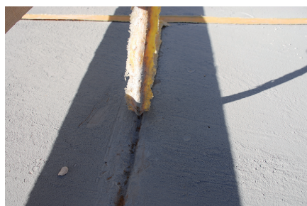
Retirado de plantillas Piedra Antigua y lavado del pavimento.
