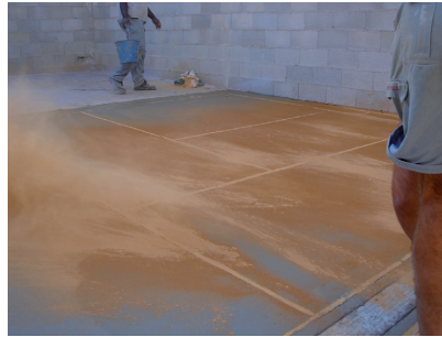
Capa de rodadura base. Applying initial hard.
