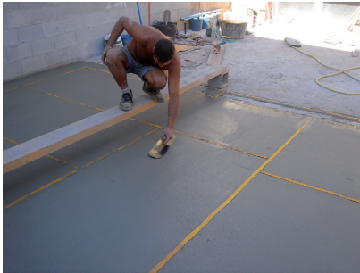
Alisado y extendido del hormigón en fresco. Distribución e introducción de plantillas con la llana de hormigón. Troweling green concrete placing straps by using concrete pool trowel.
