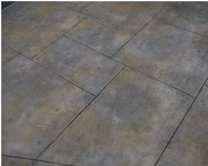
Lavado del pavimento. Pavimento terminado..
