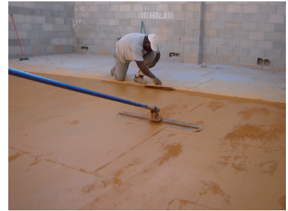
Alisado de rodadura. Espolvoreo de desmoldeante. Troweling hard. Applying release powder.
