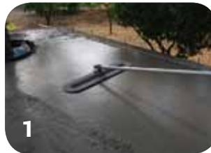
1. En los minutos que siguen a la regularización del hormigón, este se alisa permitiendo que el agua suba por capilaridad y asegurar la adhesión entre hormigón y mortero.
