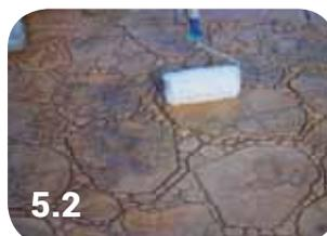
5. Pasadas las primeras 48-72 horas, eliminar el **Despi** con agua a presión y sin agua encharcada, aplicar 1-2 pasadas de resina de curado:
