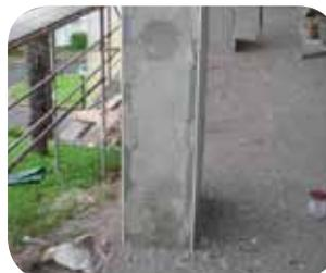
\* En zonas donde aparezca el hierro de la armadura, limpiar y aplicar mortero anticorrosión **Pavifer**, dejar secar al menos 1 hora.
