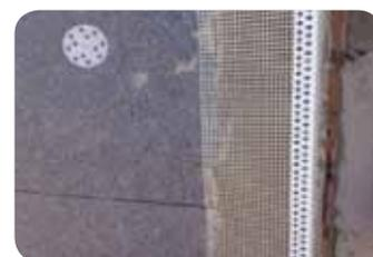
En todos los casos se respetaran las juntas de dilatación del edificio, interrumpiendo el proceso y rematar las juntas con el perfil de dilatación adecuado. El espacio interior del perfil de la junta de dilatación puede ser rellenado con **Pavex-Flexible**, a modo de caucho expandido.
