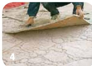
4. Con el hormigón en estado plástico se espolvorea el **Despi** que actúa como desencofrante y envejecido del pavimento. Durante el proceso de fraguado, se textura con los moldes elegidos.
