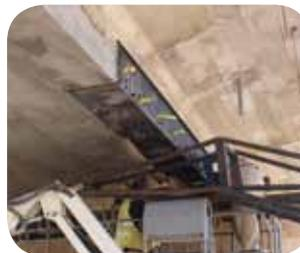
\* En zonas donde aparezca el hierro de la armadura, limpiar y aplicar mortero anticorrosión **Pavifer**, dejar secar al menos 1 hora.
