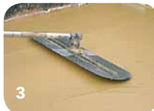
3. Alisado manual asegurando una perfecta adhesión del producto con el hormigón.
