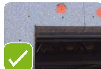
Los dinteles de las ventanas deberán ser reforzados con el perfil goterón y así evitar el paso de agua sobre el plano de la fachada.
